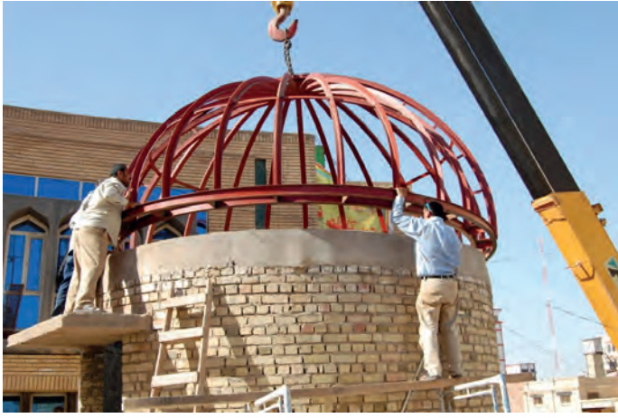
المراحل النهائية لوضع الهيكل الحديدي للمنارة
