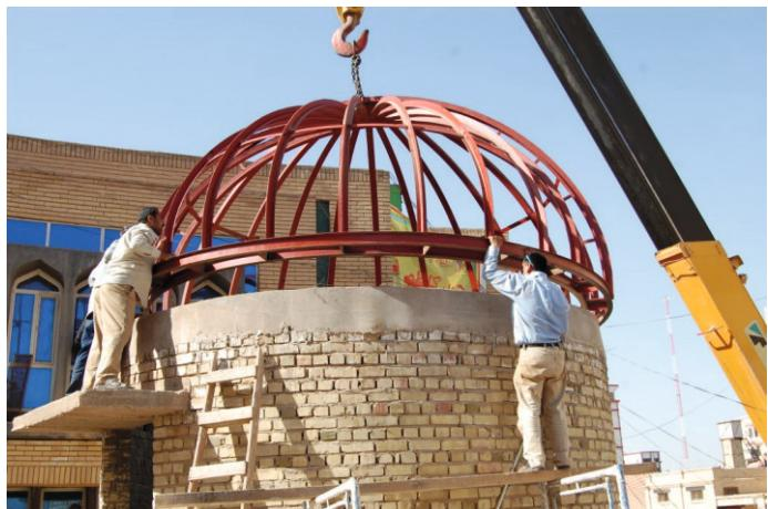
المراحل النهائية لوضع الهيكل الحديدي للمنارة
